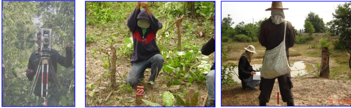
ขั้นตอนที่ 1 งานสำรวจแนวสายส่งและกำหนดตำแหน่งเสาไฟฟ้า
